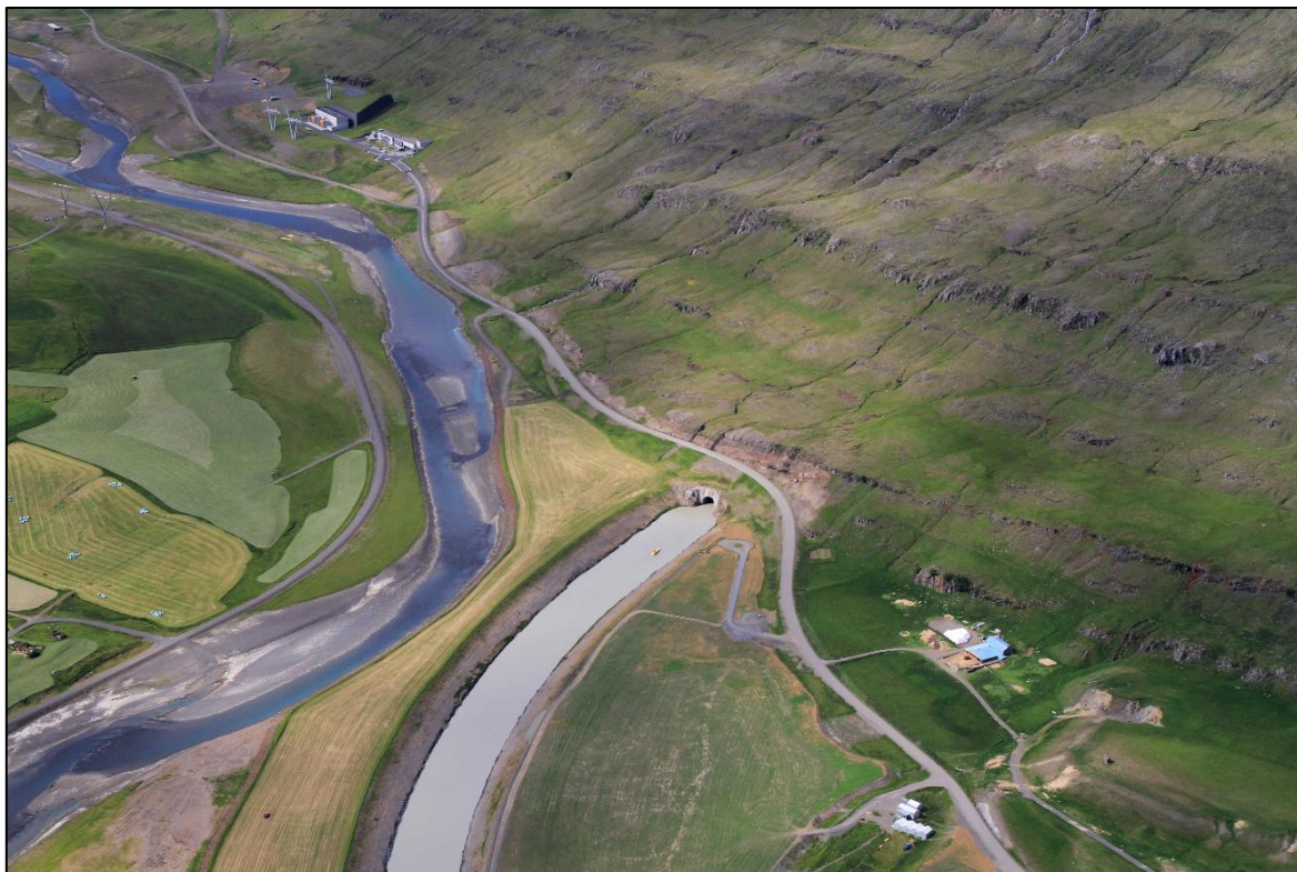
Horft yfir vettvang virkjunarframkvæmdanna í Valþjófsstaðalandi um 2010. Efst til vinstri er Fljótsdalsstöð með þjónustuhúsi og fyrir miðri mynd afrennslisskurður virkjunarinnar með Jökulsána á aðra hönd. Neðst til hægri eru beitarhúsin í Hvammi og Hvammseyri, þar sem vinnubúðarþorp virkjunarinnar stóð. Ljósmynd: Skarphéðinn G. Þórisson.
